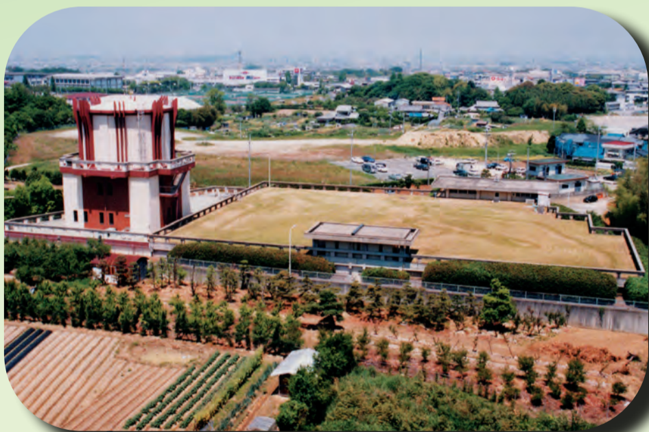
低区配水池兼高架水槽
